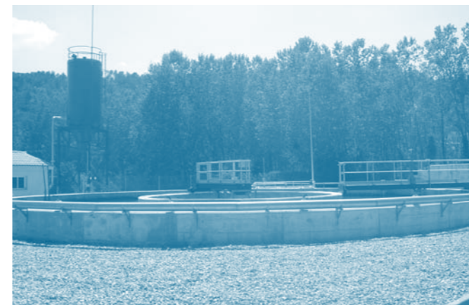
Vista de les instal·lacions de la depuradora de Carme.
