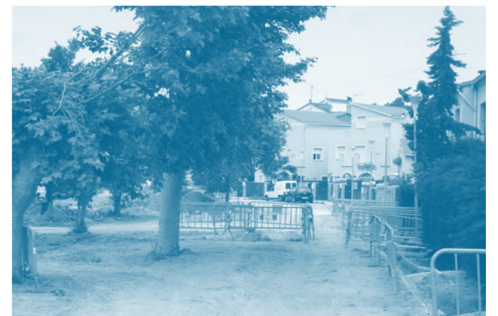
Ja han començat les obres d'urbanització del carrer Font Frigola
