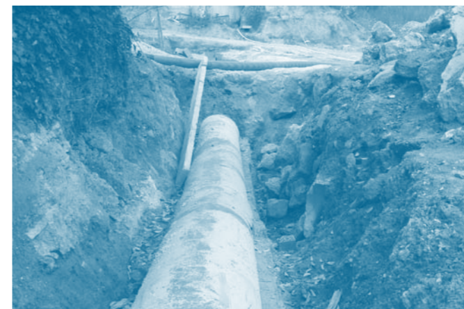
Detall del sifon del rec una vegada connectat i després de comprovar que no hi ha fuites
